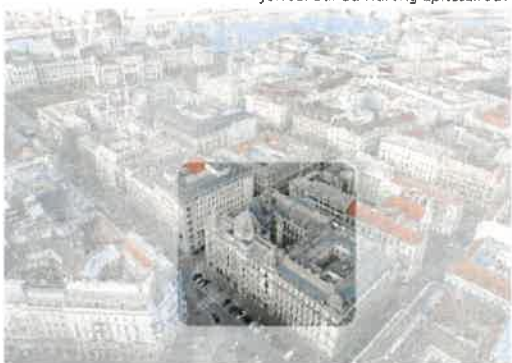
Az épülettömb viszonyai a környezethez forrás: Google Earth Pro felvételei
