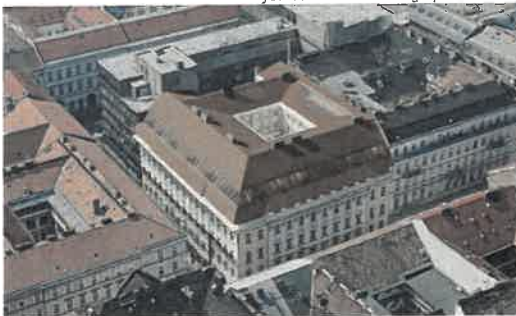
Az épülettömb magassági viszonyainak rendezése, tervezett tető kialakítással forrás: Google Earth Pro felvétel
