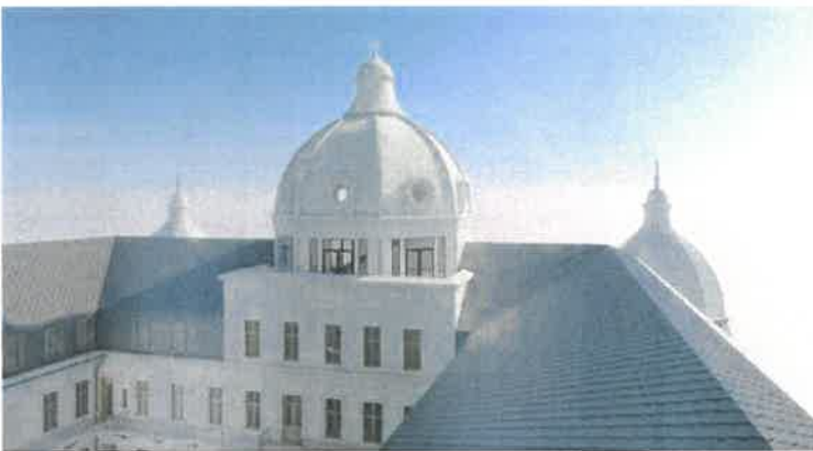
Kupolákon elhelyezett nyílászárók, a belső udvar felé történő megnyitás lehetőségével
