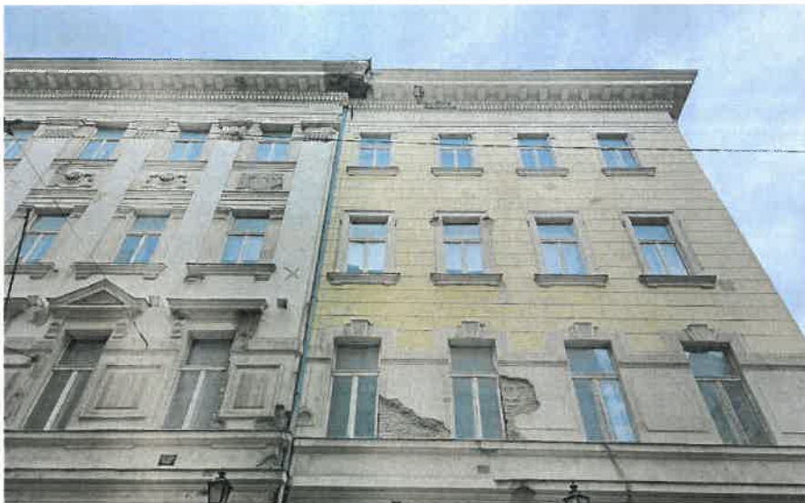
Tüköry utca felőli homlokzat
