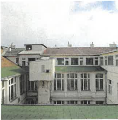
Utólagos lift gépház
