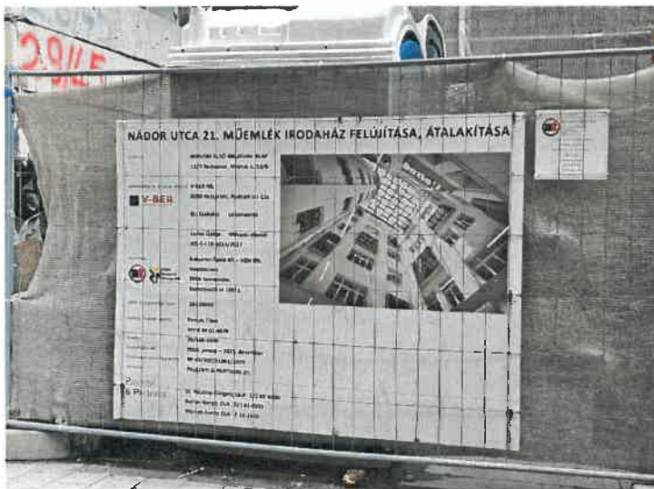
Nádor utca 21. műemlék épület felújítását hirdető tábla a közterület felett
