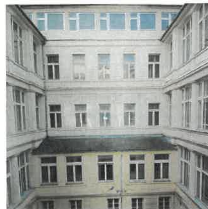
Belső udvar utólagos hozzáépítéssel
