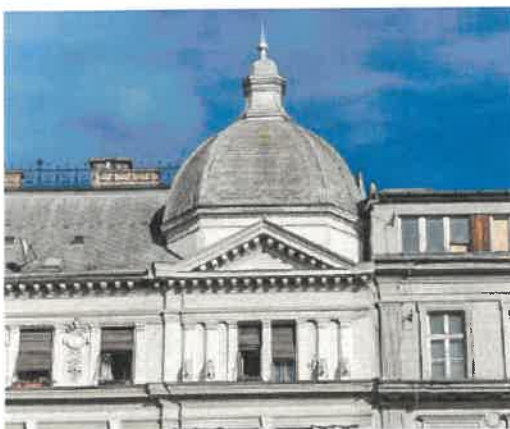
Kovácsoltvas korlát, timpanonok, kupola forrás: Bánáti Hartvig Építésziroda koncepcióterve
