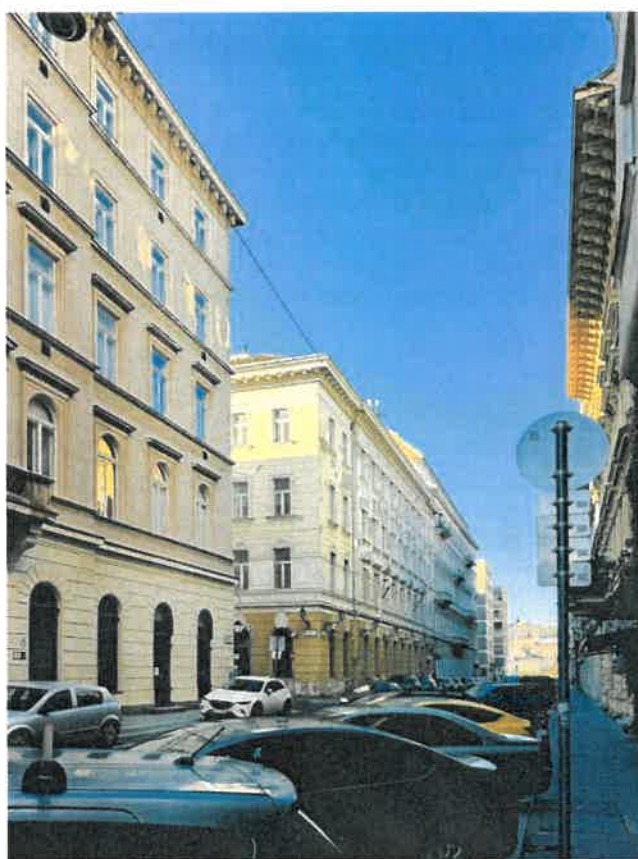
Rálátás a meglévő épületre a Széchenyi utca felől forrás: Bánáti Hartvig Építésziroda
