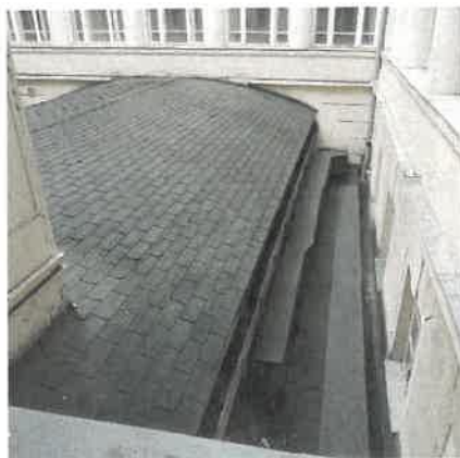
Beépített fűdvar utólagos tetőfedése
