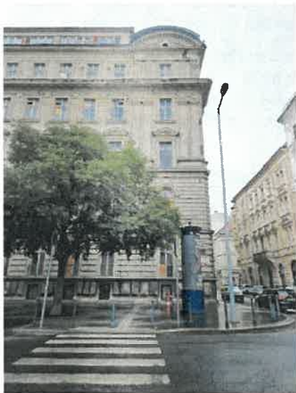
Hold utca – Báthory utca kereszteződése menti szomszédos épület
